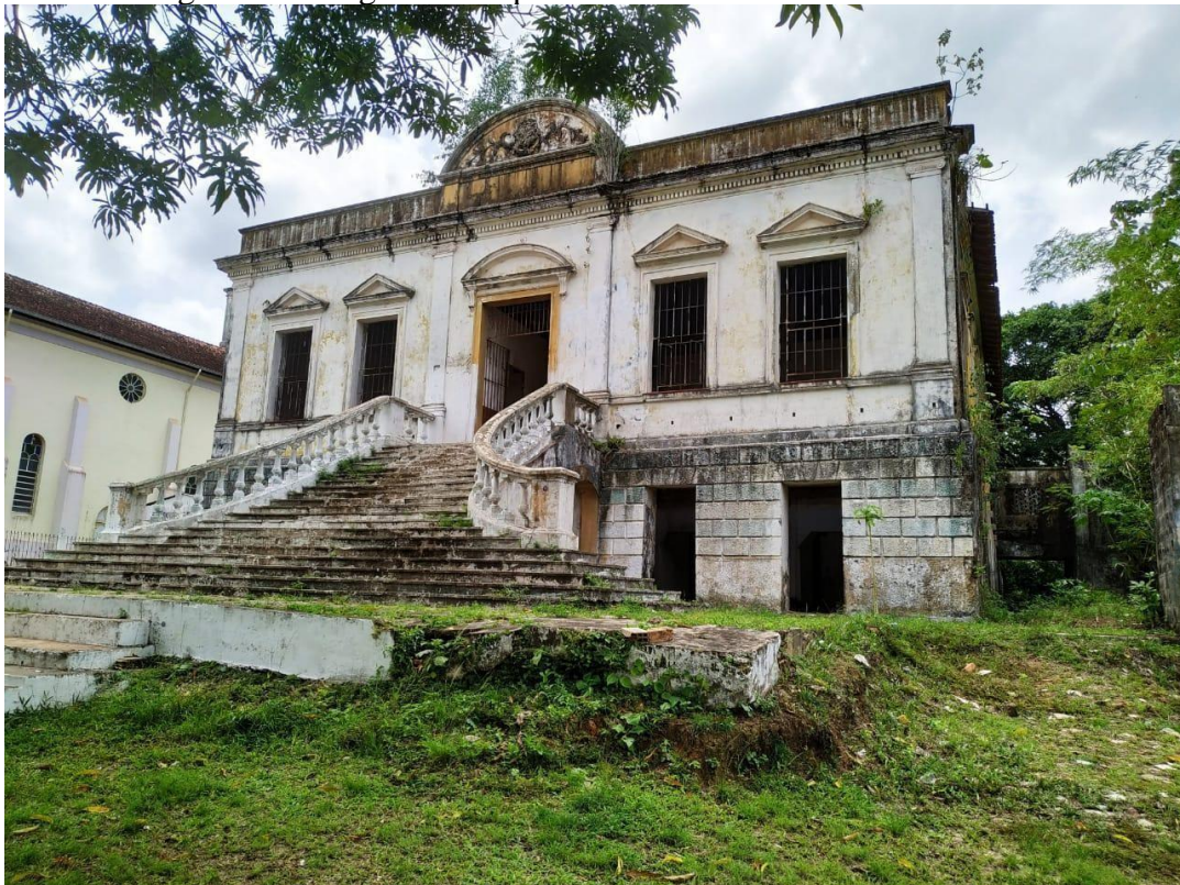
Figura 2 - Antigo Prédio que funcionava a Escola João Paulo II
