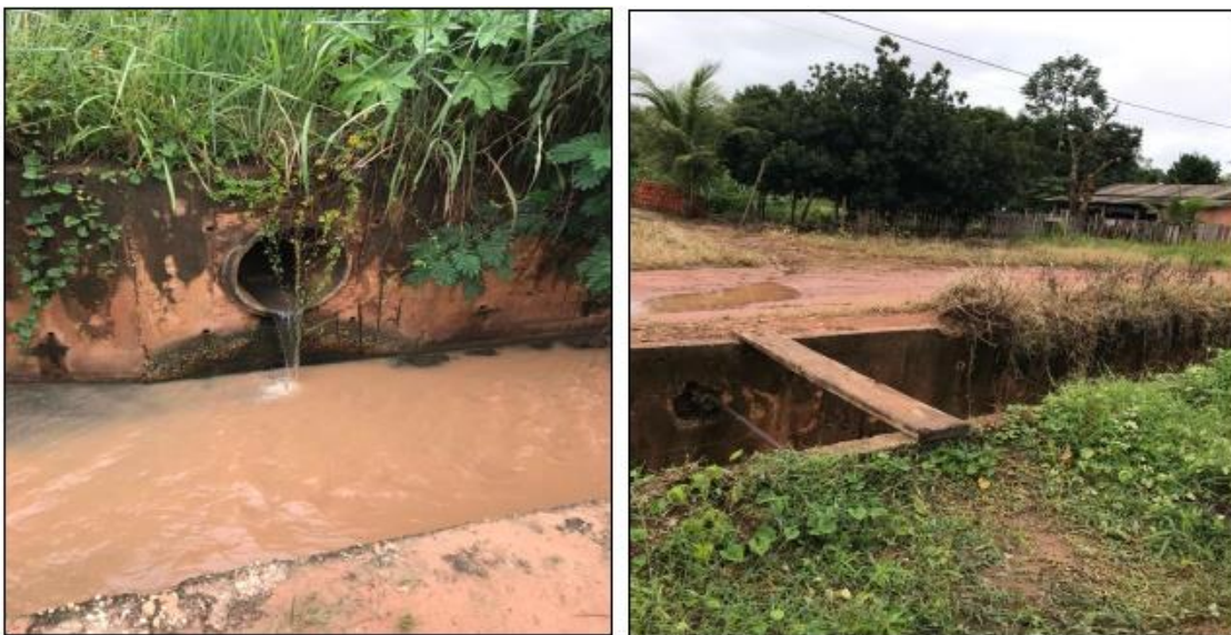
Figura 2 – Falta de acessibilidade e saneamento no bairro
